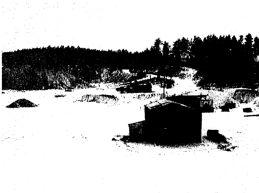
Bild 7: Vy över fastigheten mot norr. Närmast i bild, byggnad där blåstring förekommit.
